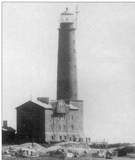
Mäktigt reser sig Bengtskärsfyren över skärets klippor. T.h. nedanom fyren står Åbo kustregementets rekryter uppställda för faned. Bild: Mathias Luther.
